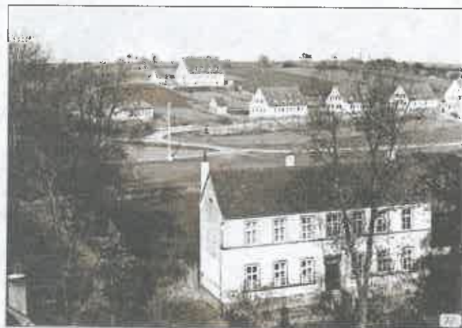
Blick über das ehemalige Pfarrhaus am Schlossgelände hinüber zum Taubenberg, wo nach dem Zweiten Weltkrieg eine neue Siedlung entstand. Foto: Gemeindefacharchiv Euerbach
