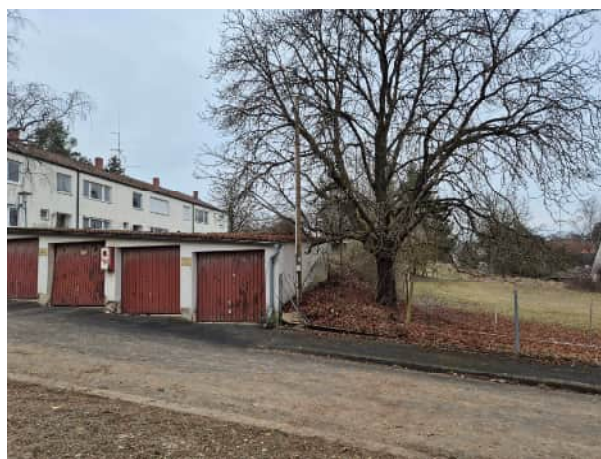
Böschung zwischen geplantem MD/ b - u. WA-Gebiet
