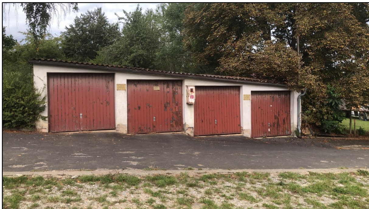
Abb. 5: Zu sanierende Garagen
