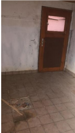
Abbildung 17: Bsp. Kellerraum: Tür geschlossen
