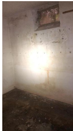
Abbildung 16: Bsp. Kellerraum: Fenster vergittert
