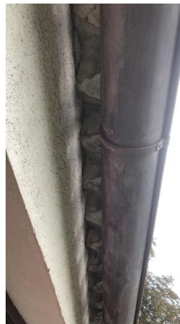
Abbildung 20: Garagen: kein Zugang unters Dach
