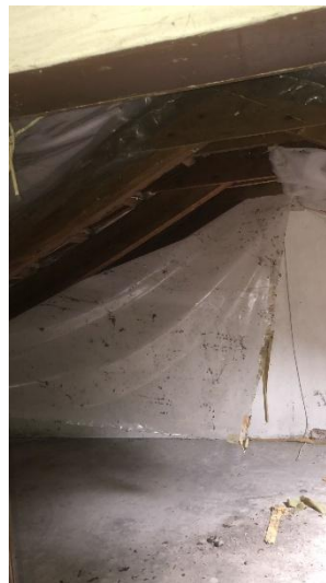
Abbildung 10: Dachgebälk, teils abgehangen
