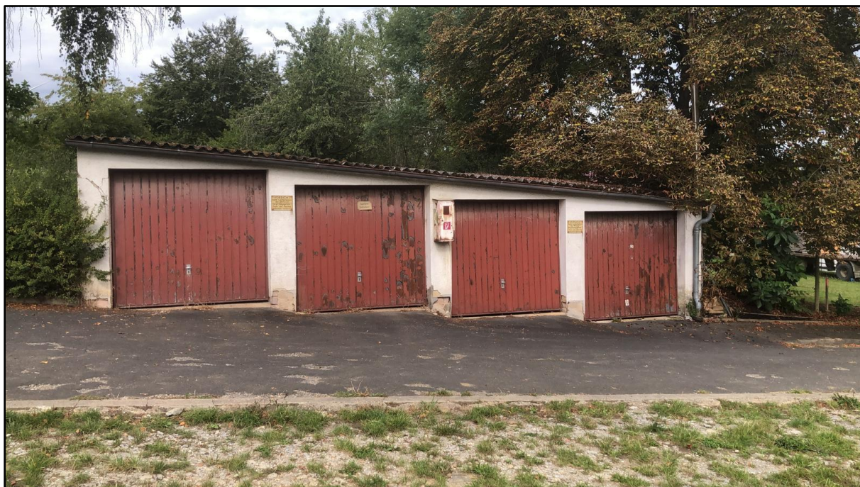
Abb. 5: Zu sanierende Garagen
