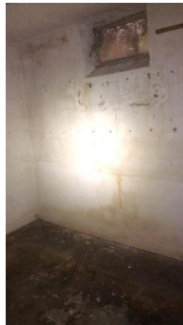
Abbildung 16: Bsp. Kellerraum: Fenster vergittert
