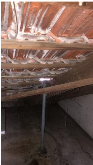
Abbildung 9: lose Dachziegel als Einflugsmöglichkeit
